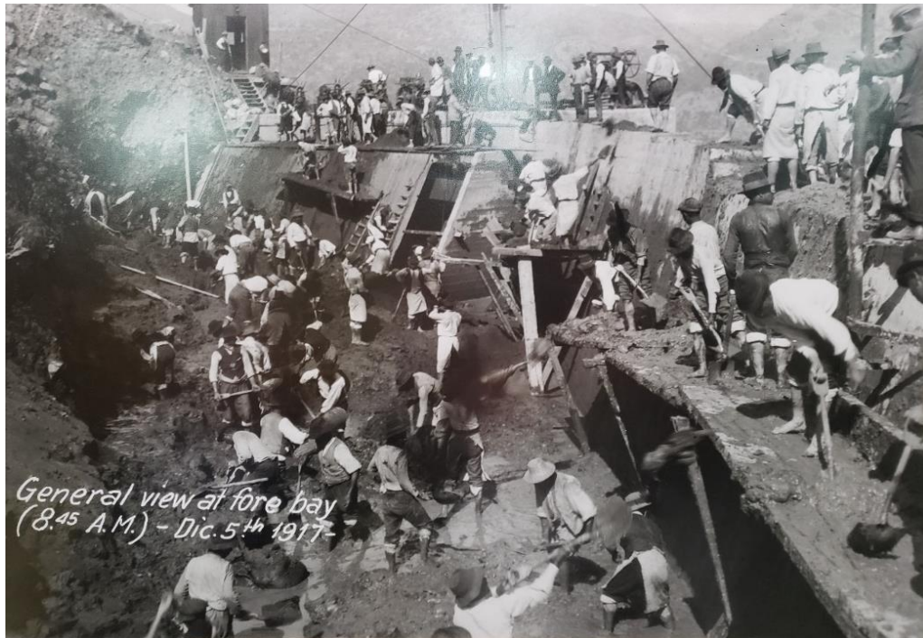
Obreros trabajando. General View at fore bay, 1917 recuperado de https://www.enterreno.com/moments/mina-el-teniente-1917s
