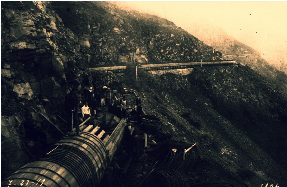
Ilustración 22.- Construcción de Bocatoma, Pangal 1919 (Fuente: Stgonosltalgico, 2014).
