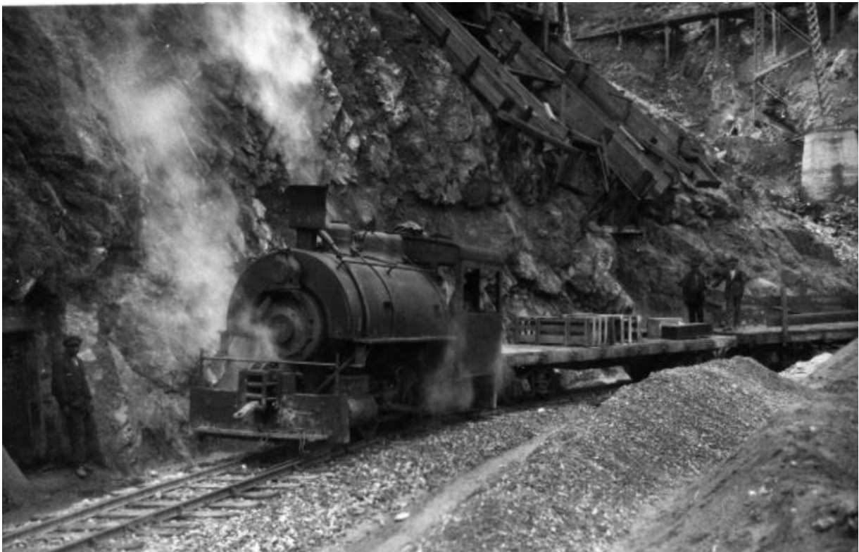
Ilustración 18.- Ferrocarril Sewell, 1920 (Fuente: CODELCO, 2018).
