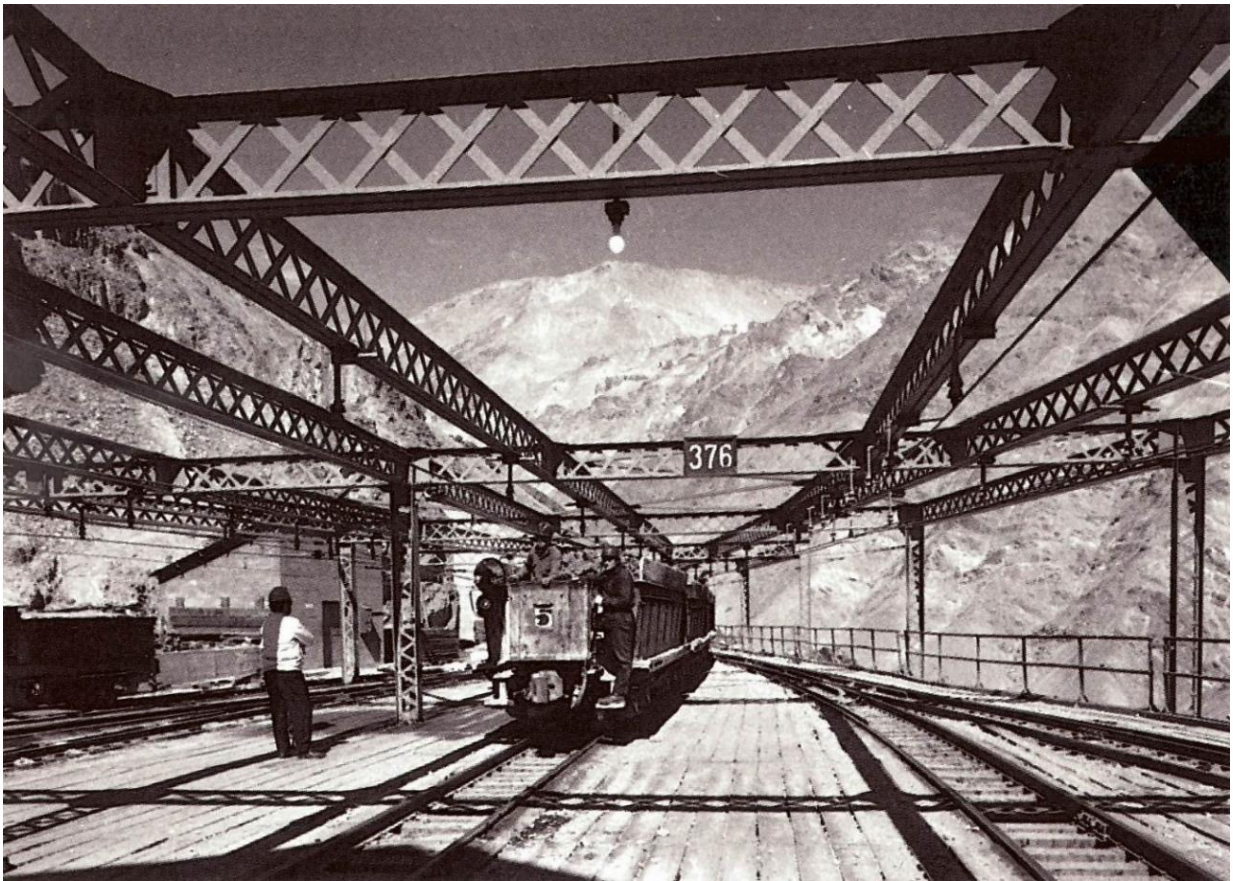
Locomotora Eléctrica, estas provenientes desde el interior de los túneles cargados con minerales, estos son depositados en los buzones para el siguiente proceso Fuente: a investigar
