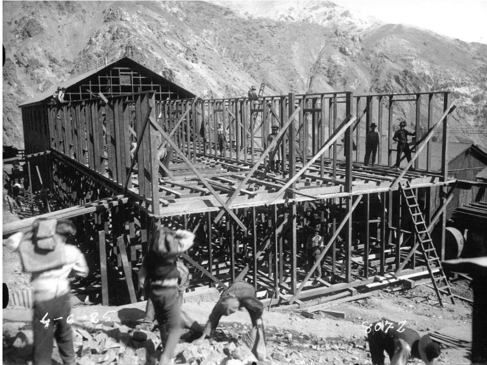
Construcción Camarotes Campamento Sewell 1925 Clásica construcción Norteamericana en madera. Fuente: Archivo Sewell, recuperado de https://www.enterreno.com/moments/construccion-camarotes-campamento-sewell-en-1925
